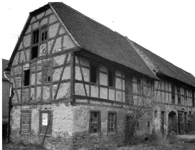
Haus Nr 31 in Großbuch
