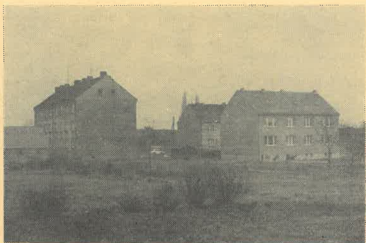
Nationales Aufbauwerk, 12 und zweimal 4 Wohnungseinheiten
